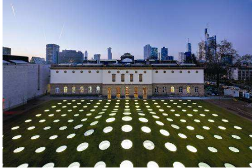
Bild 1: 195 kreisrunde Oberlichter bringen Tageslicht in die Gartenhallen und verwandeln den Garten bei Nacht in einen leuchtenden Lichtteppich.
