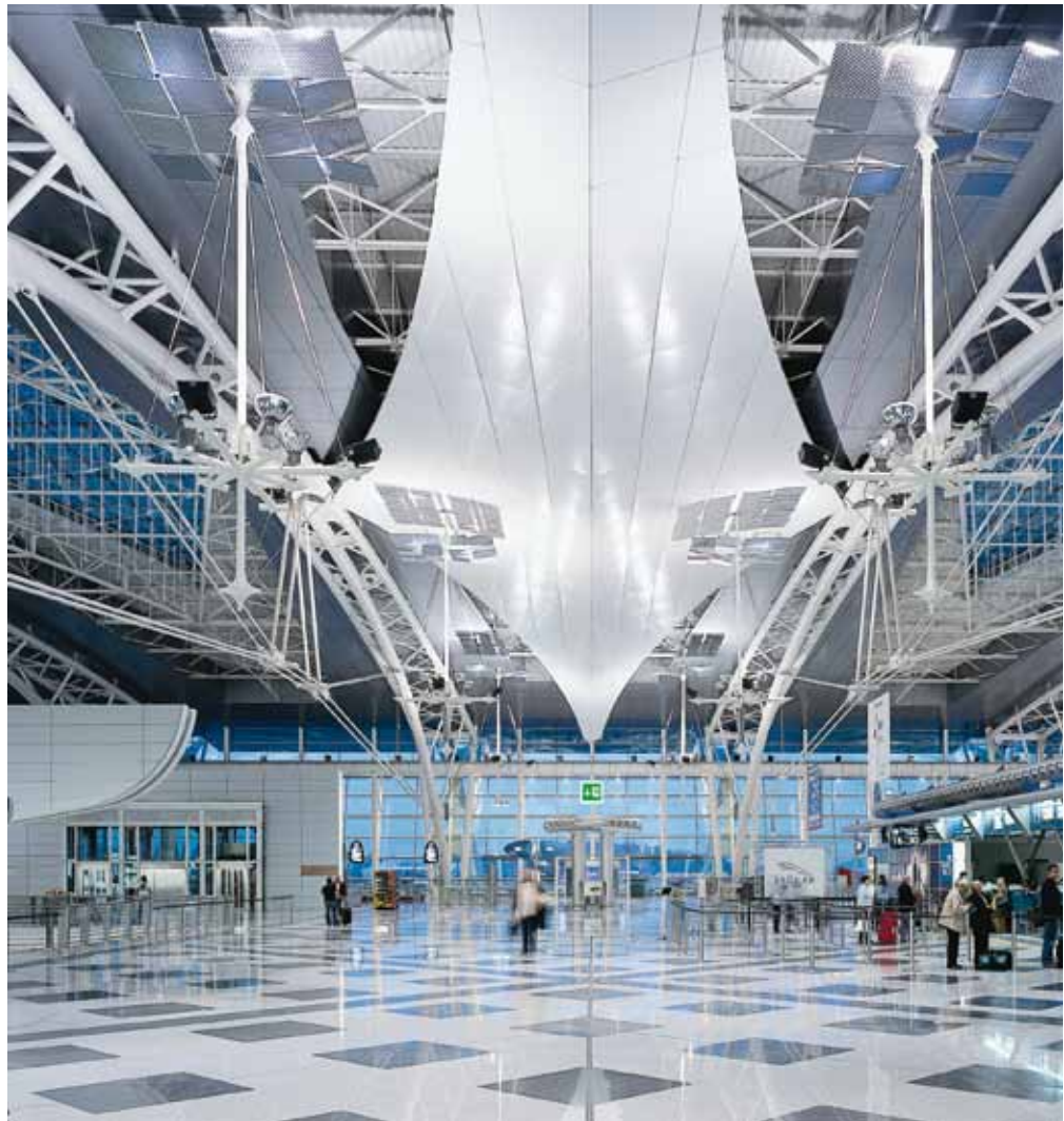
B7 | Der CUBESIGN Würfel an der Decke oder daran abgependelt ist auch in hohen Hallen stets im Blickfeld der Passanten, ganz egal an welcher Stelle sie sich gerade aufhalten.
