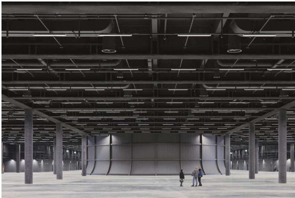
Bild 3: Optimale Beleuchtung für die Aussteller: Die Messehallen stattete Zumtobel mit dem effektiven Lichtbandsystem Tecton aus.
