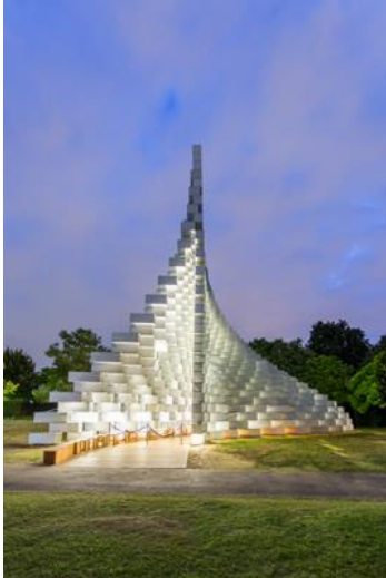
Bild 2: Die Lichtlösung erzielt das von BIG gewünschte Strahlen in der Nacht,. Im unteren Bereich ist es stärker und betont die wellenförmige Struktur, nach oben hin verläuft es allmählich, um mit der Struktur und dem Nachthimmel zu verschmelzen.
